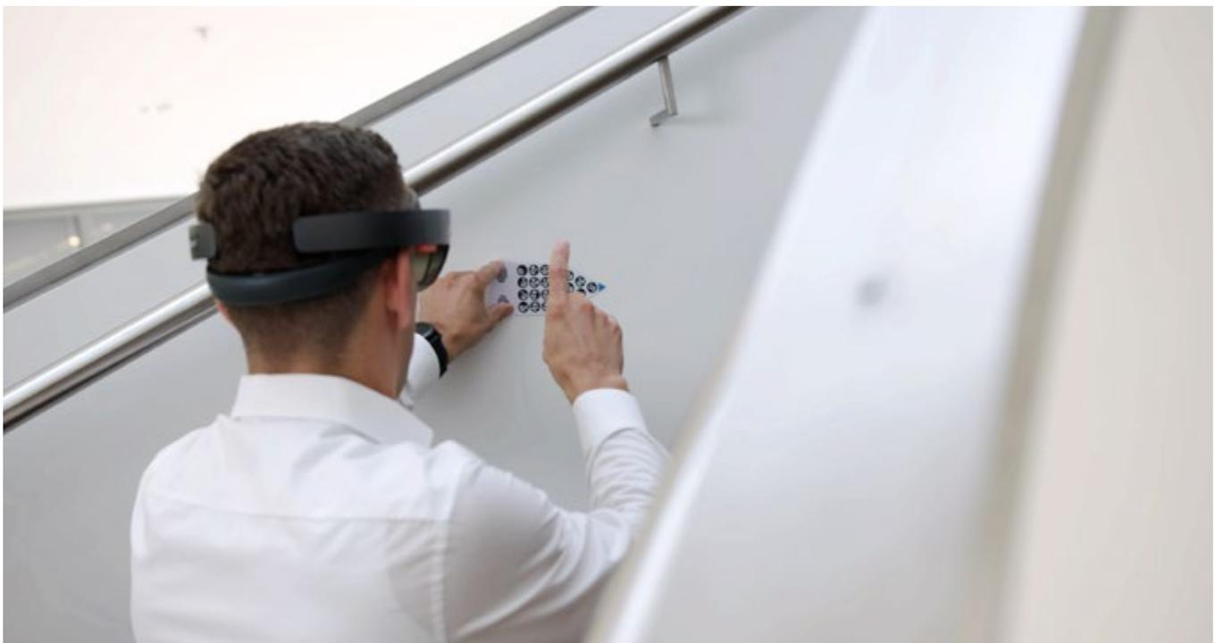
Mit einem Marker wird das Treppenhaus Schritt für Schritt ausgemessen
